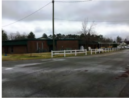
2). West Elevation - Feb 08, 2017
