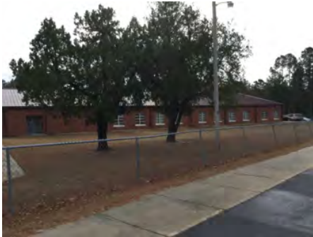
4). West Elevation - Dec 08, 2016
