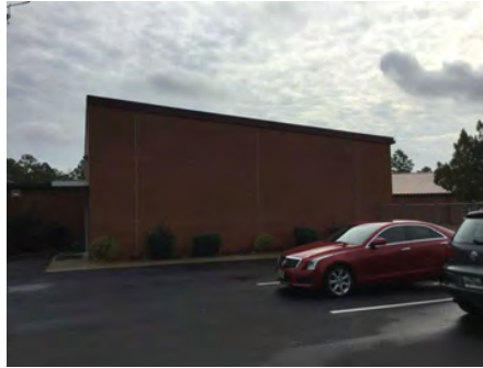
2). West Elevation - Dec 08, 2016
