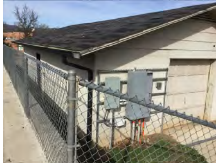
2). West Elevation - Feb 08, 2017
