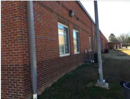
4). West Elevation - Feb 09, 2017
