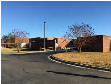
4). West Elevation - Dec 08, 2016
